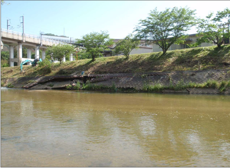
着工前 着手前
