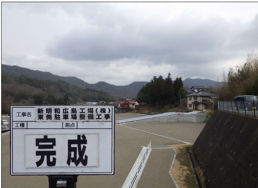
完成 完 成（全景）
