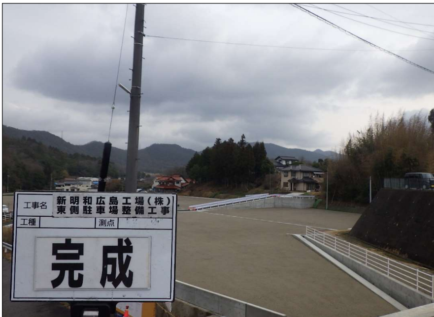
完成 完 成（全景）
