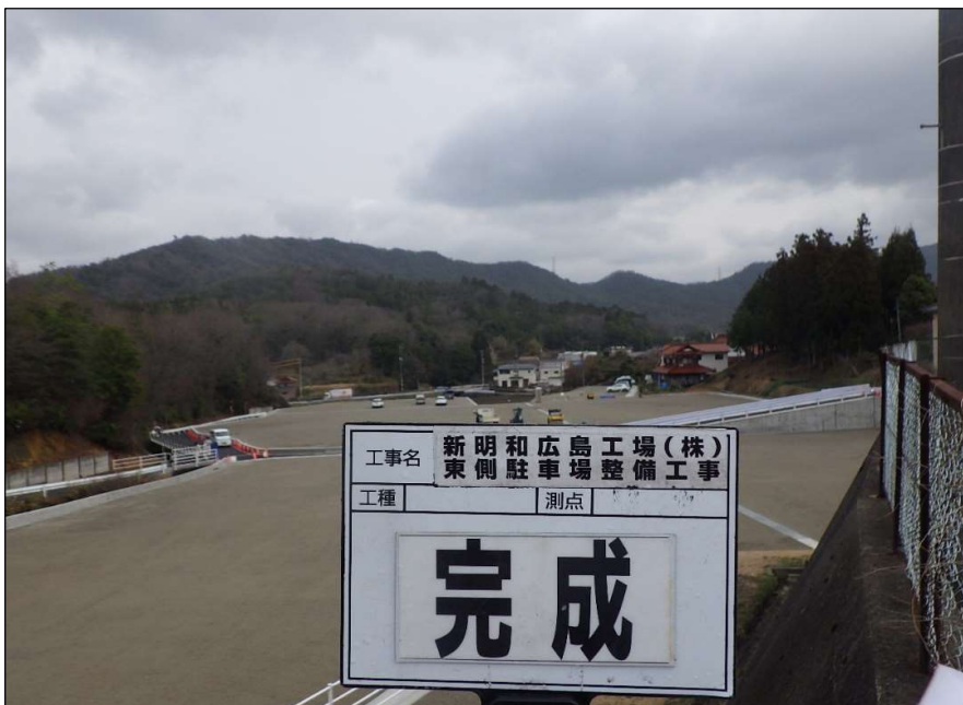
完成 完 成（全景）
