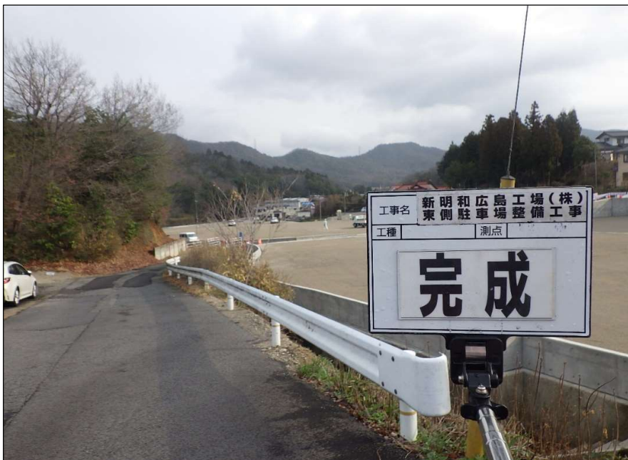
完成 完 成（全景）
