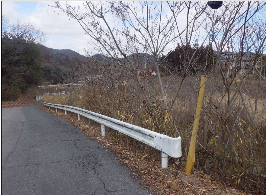
着工前 着工前（全景）
