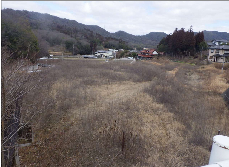
着工前 着工前（全景）
