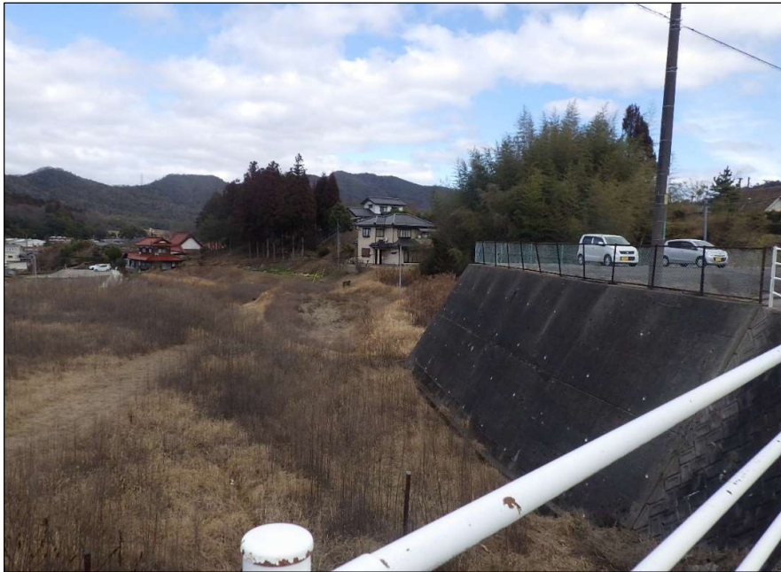
着工前 着工前（全景）
