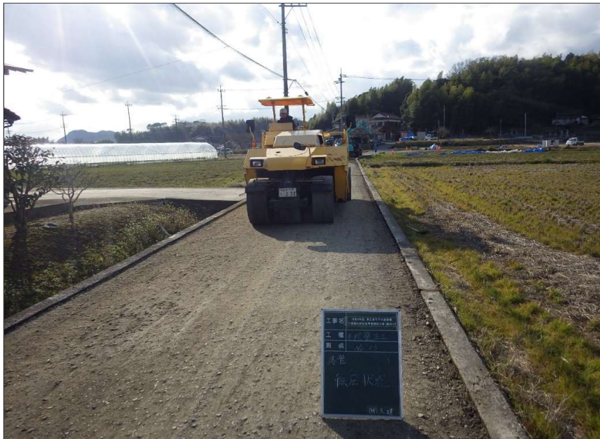
不陸整正工 路盤転圧状況 No. 13
