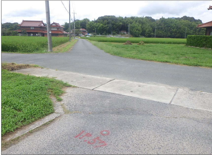
開削工 着工前 IP. 57
