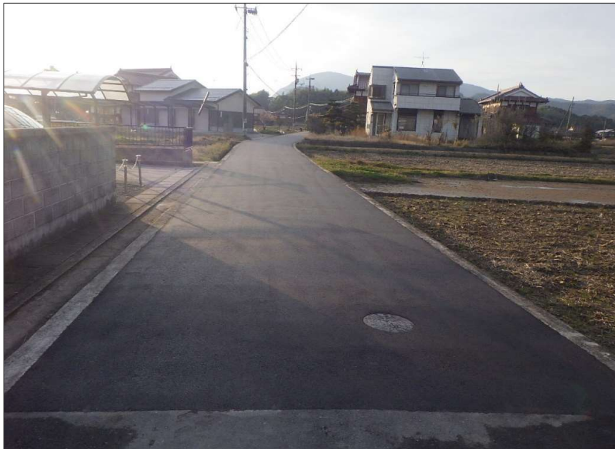
開削工 完成 IP. 60-2. 50m
