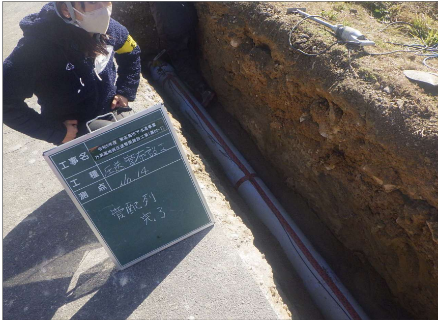
開削工 管配列完了 No. 14
