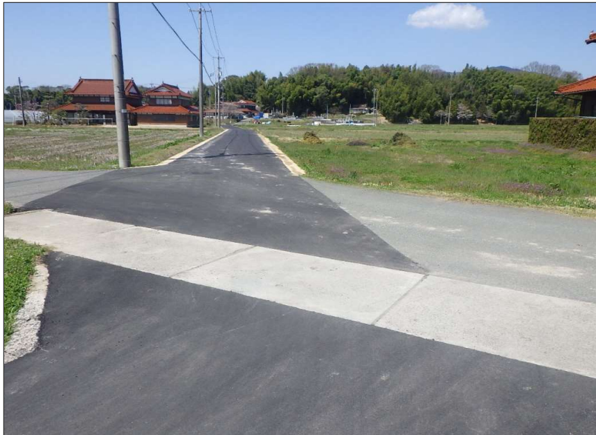
開削工 完成 IP. 57
