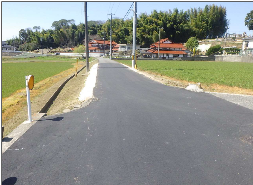
開削工 完成 IP. 44
