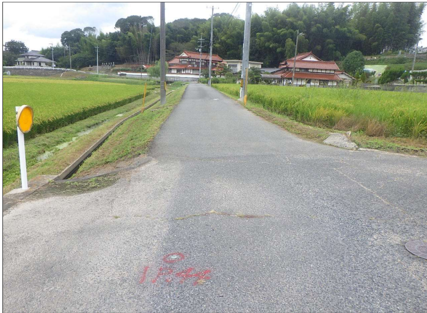
開削工 着工前 IP. 44
