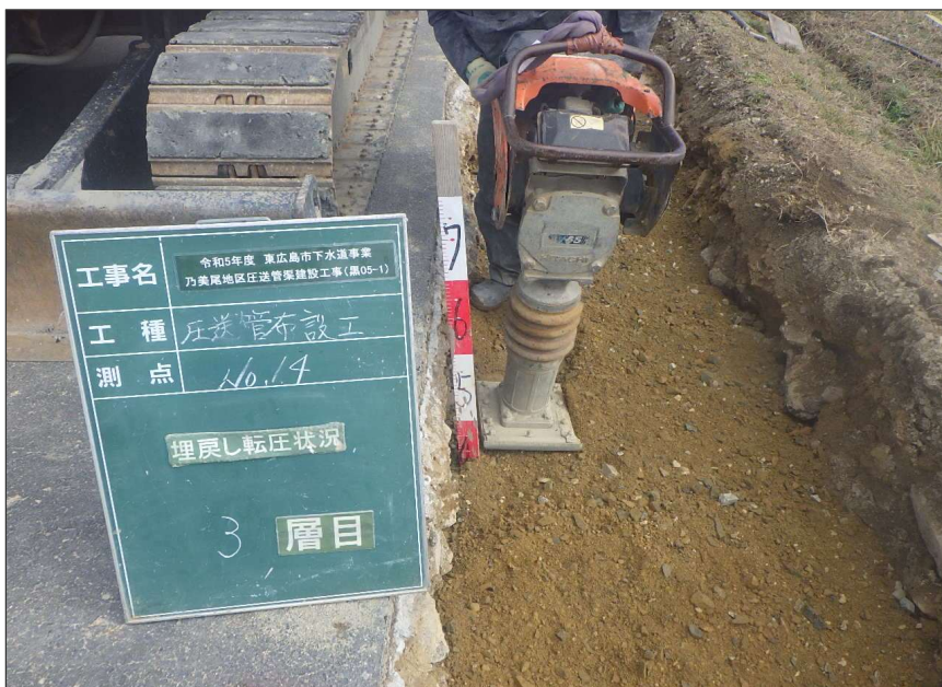
開削工 3層目 埋戻し転圧状況 No. 14
