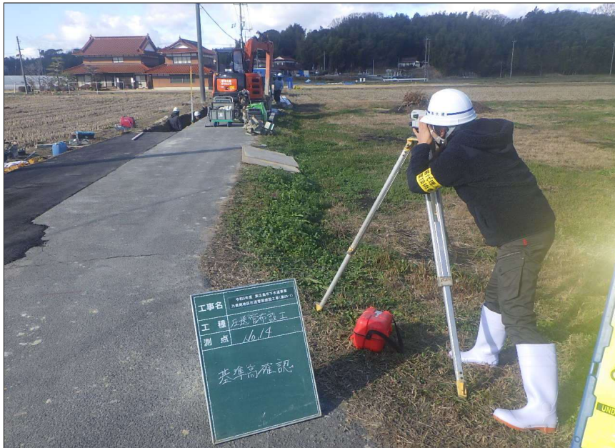
開削工 基準高確認 No. 14
