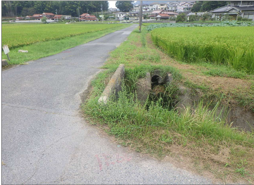
開削工 着工前 IP. 50
