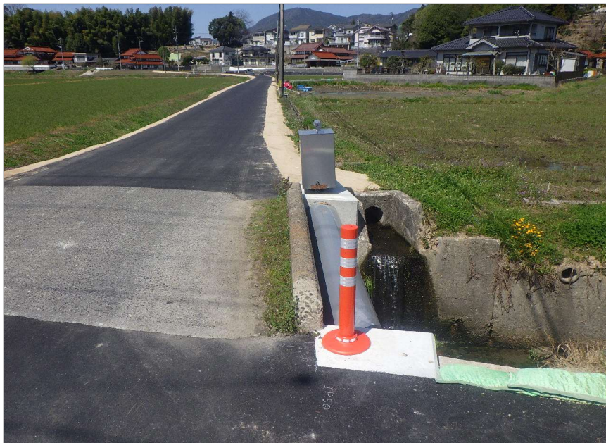
開削工 完成 IP. 50
